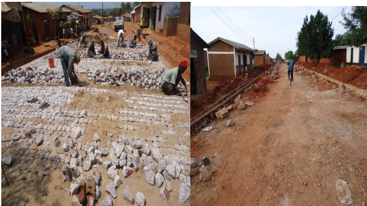
Picha Na 5: Ujenzi wa barabara za mawe ukiendelea
